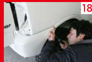
18 リアバンパーの取り付け。現物合わせしてから取り付け穴を開けてビスで固定。
