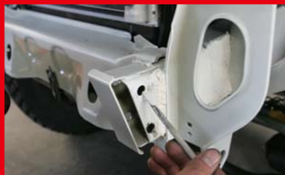
12 小さな気遣いと大きな安心。穴開け後、エナサンダーでバリを落とし、鉄板の地が出た所を断面に錆止めの塗料を塗布。
